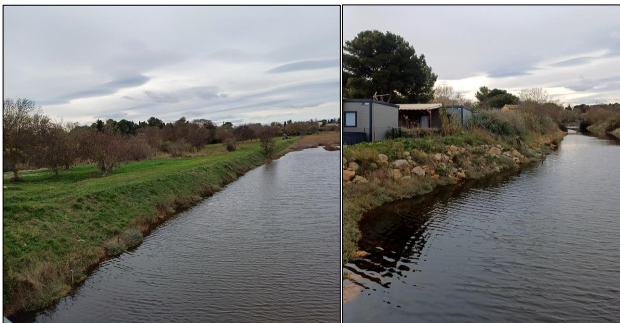
Figure 6 : Merlons en terre sur le ruisseau du Pallas à Mèze (SAM, 2025)
