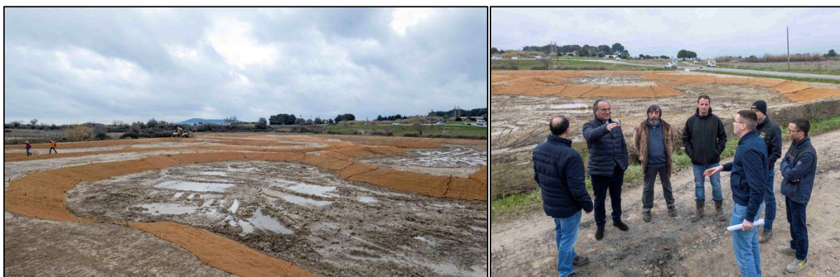
Figure 16 : Restauration hydromorphologique du cours d'eau de la Bourbou à Loupian (SAM, 2025)
