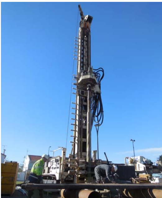
Lancement des travaux Dem'Eaux à Sète © SMBT
